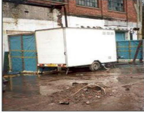
Şekil 4.6. Karantina bölgesi duş ünitesi.
