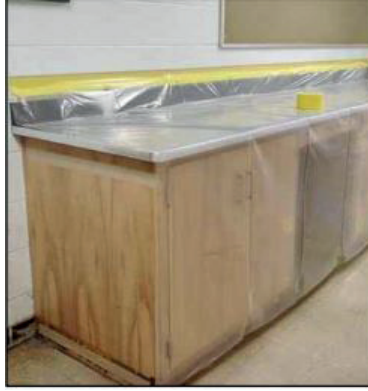
Şekil 4.10. Malzemelerin kaplanması (İş Sağlığı ve Güvenliği Genel Müdürlüğü, 2019).
