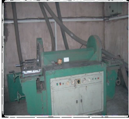
Şekil 1.3. Asbest tozu bulunan havalandırma sistemi parçası (Arseven, 2005).
