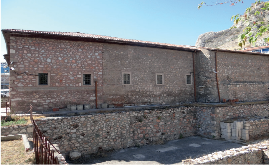
Fotoğraf 4: Tokat Gökmedrese'nin kuzey cephesi (2013)
