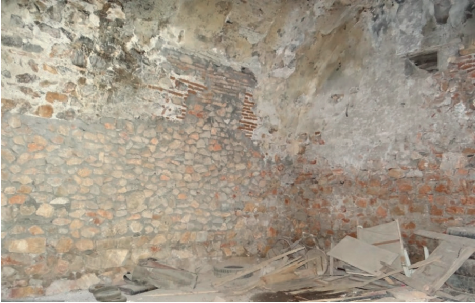
Fotoğraf 7: Yapı kalıntısındaki büyük eyvanın bitişiğindeki geniş mekân (2017)
