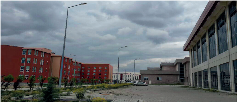
Şekil 7. Yerleşke otopark aydınlatmasında kullanılan armatür-2
