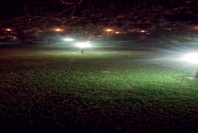
Şekil 13. Yerleşke yeşil alan aydınlatmasında kullanılan armatür-6
