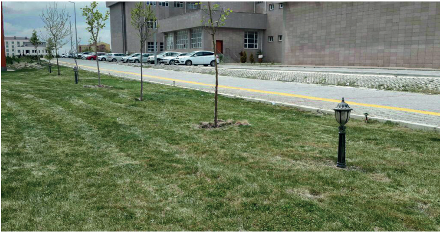
Şekil 8. Yerleşkenin yeşil alan aydınlatmasında kullanılan armatür-1
