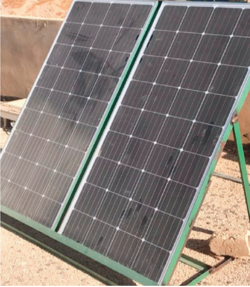
Şekil 9. Fotovoltaik panellerde 3 ay sonra oluşan görüntüler(Sağ taraftaki PV Panele nano kaplama uygulanmış sol taraftaki PV Panele uygulanmamış)[17].
