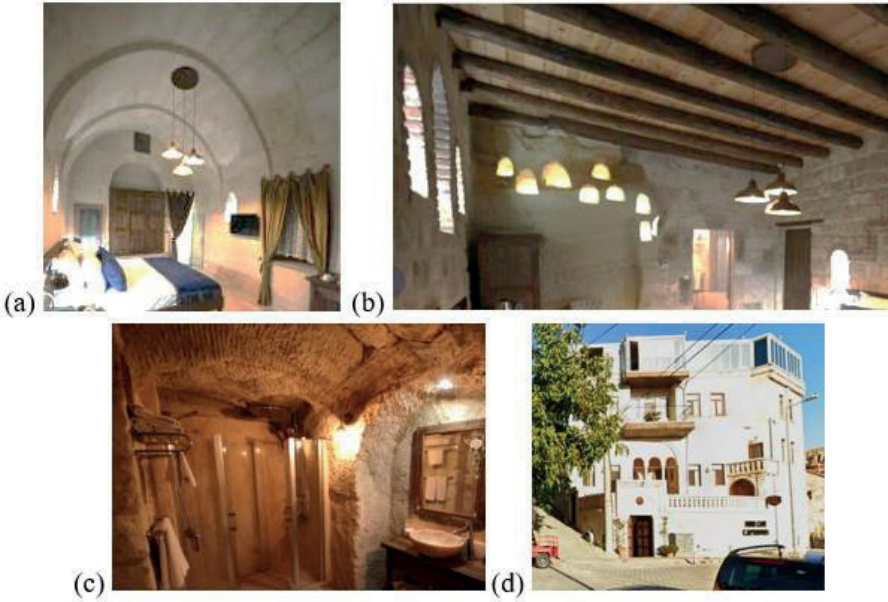
Şekil 11. a. (Kemerli) Tonoz tavan b. Hezen tipi tavan d. Kaya tavan c. Çatıda özgün olmayan eklemeler
