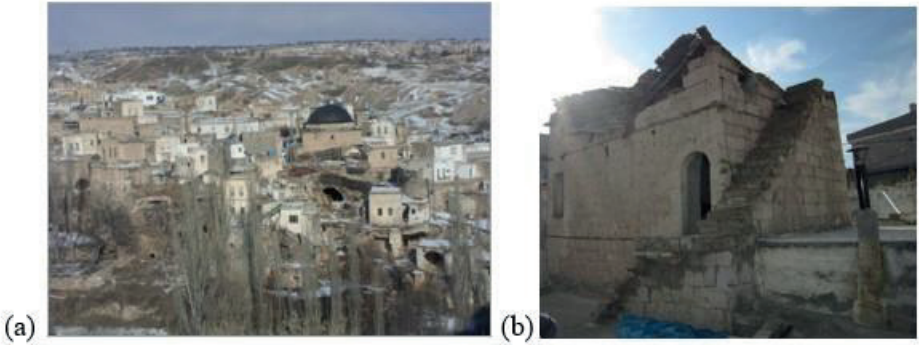
Şekil 21. a. Düz dam ağırlıklı çatıların genel görünümü b. Taş merdiven
