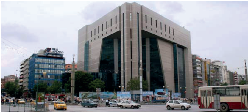
Şekil 9. Kızılay Meydanı ve Yeni Kızılay AVM binası (URL-4)
