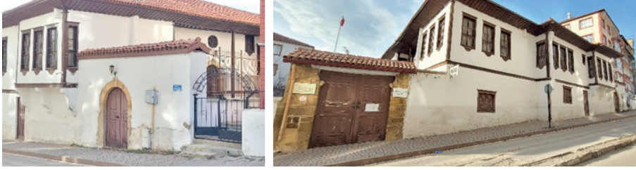
Şekil 5. Nizamoglu Konağı'nın sokağa bakan cephesi ve giriş kapıları, 2024
