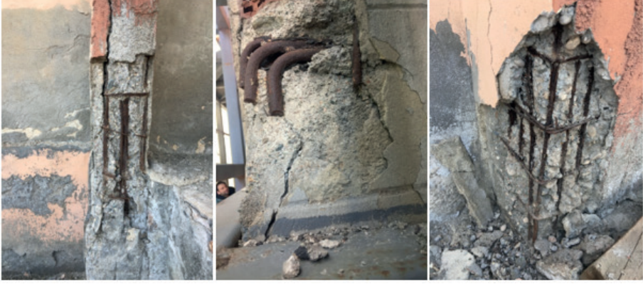
Şekil 1. Betonarme Çeliğinde Pas oluşumu
