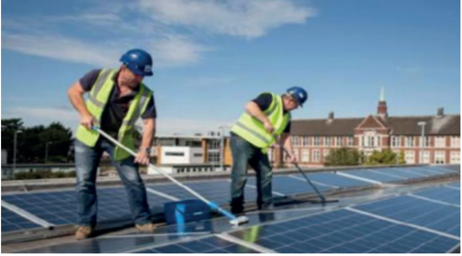
Şekil 5. Güneş panellerinin fırça ile manuel temizlenmesi ve yıkama [17].
