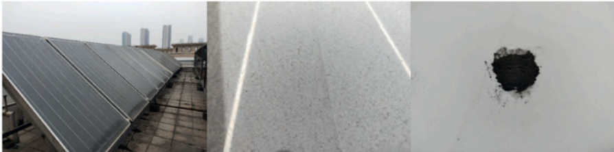
Şekil 3. Güneş panel yüzeylerinde endüstriyel çatı kurulumlarında oluşan tozlanma [13].
