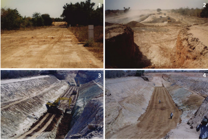
Şekil 6. Burkina Faso'da bir yeraltı barajı inşaatı (Japonya Çevre Bakanlığı, 2004).
