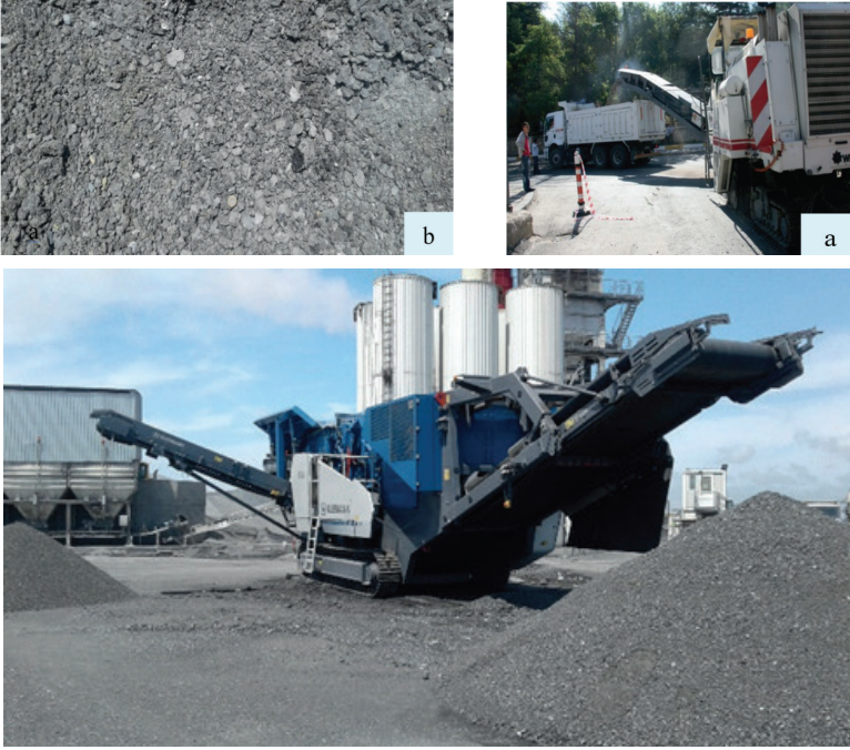
Şekil 1. a) Kaplamanın Makina (Freze) ile kazınması b) Kazınmış Asfalt
