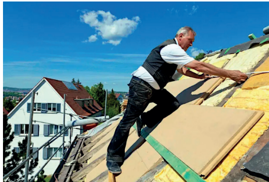
Şekil 36: Çatıda Destek Elemanı Olarak MDF Kullanımı (URL 33).
