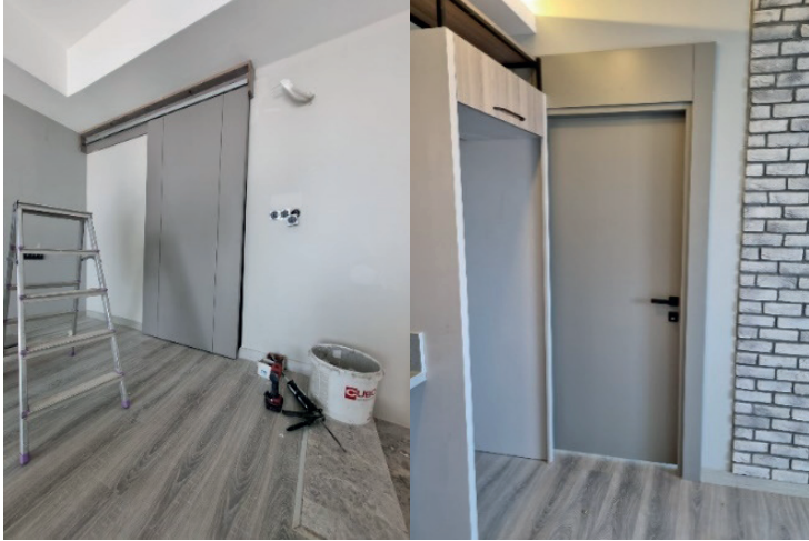
Şekil 8: Kapıda MDF Üzeri Lake Boya Uygulaması (URL 6).
