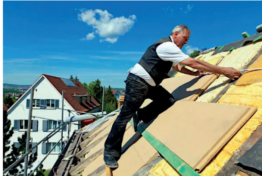
Şekil 36: Çatıda Destek Elemanı Olarak MDF Kullanımı (URL 33).
