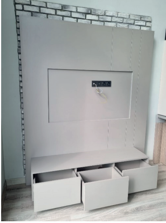
Şekil 17: MDF Üzeri Lake Boya uygulaması Yapılmış TV arkası Panel Uygulaması ve Lake Boyalı MDF'nin TV Ünitesinde Kullanımı (URL 15)
