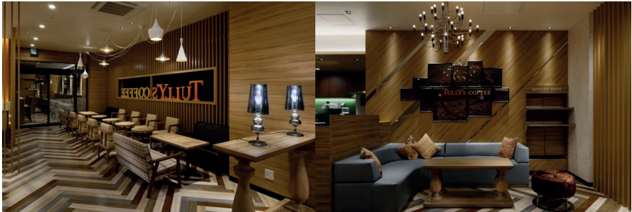
Şekil 23: Tullys Kafe, Fukuoka, Japonya MDF Duvar Paneli Uygulaması (URL 20).
