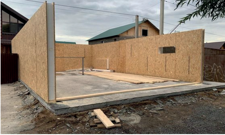
Şekil 17. Prefabrik ev yapımı (Url-10).
