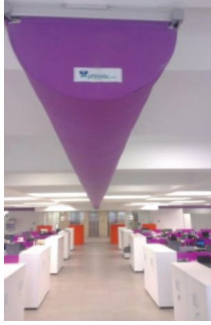
Şekil 5. Maçka Binası Kumaş Kanal Uygulaması (Yazar Arşivinden, 2015).
