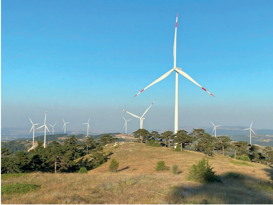
Şekil 1. Yatay eksenli, 3 kanatlı türbinlerden oluşan rüzgar enerji santrali (RES).
