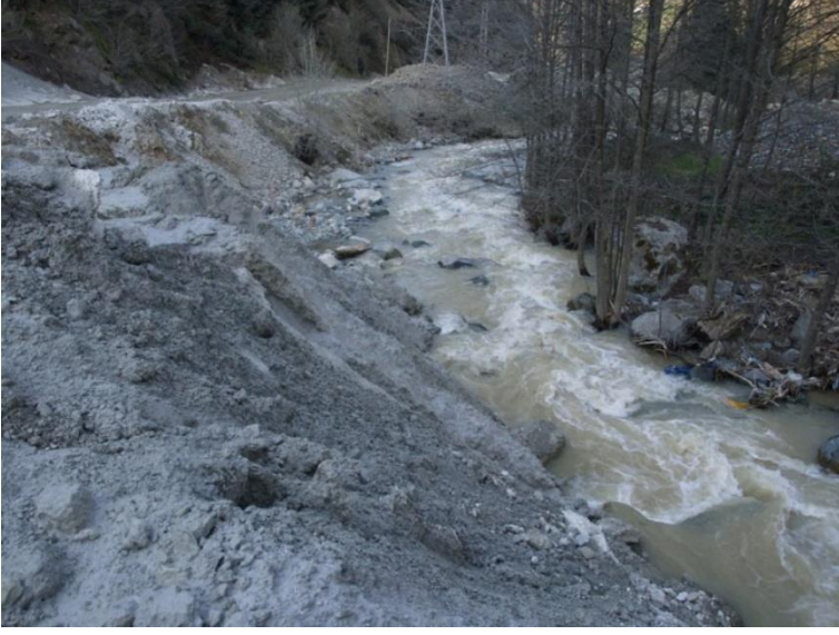
Şekil 6. Murgul'daki Kabaca Deresi üzerinde inşa edilen çoklu nehir tipi HES tesisleri nedeniyle nehir yatađına çok yakın yapılan yolun ve dere yatađına atılan inşaat atıkları
