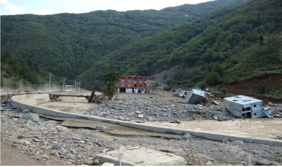
Şekil 3. Dere yatağının çok yakınında veya içinde inşa edilen ıslah yapıları ve yolların sel ve taşkından zarar görmesine çarpıcı bir örnek (Borçka, Artvin).
