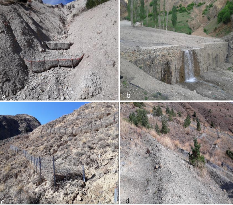
Şekil 2. Erozyon kontrol tesisleri; kafes tel eşik (a), tersip bendi (b), kafes tel çit (c), teras (d)
