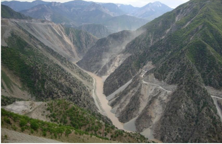
Şekil 7. Artvin'de 2012 yılında tamamlanan Deriner Barajı nedeniyle yenilenmek zorunda kalınan yüzlerce km'lik yol ađının inşası sonucunda nehir yatađında meydana gelen tahribat
