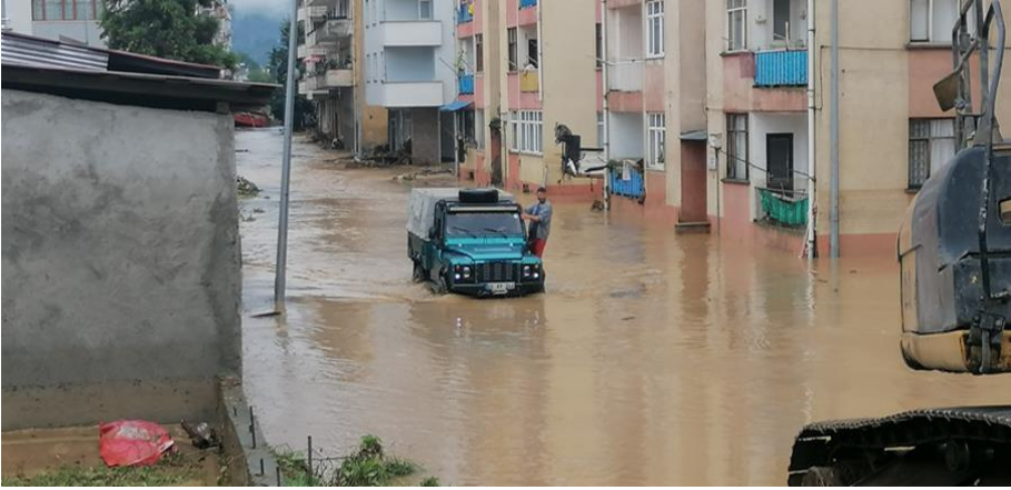
Şekil 5. Sel sularının doğal yataklarından taşarak tarım alanlarını ve/veya yerleşim yerlerini basarak taşkın oluşturması ve sel sularının drenajındaki yetersiz alt yapı sistemi (Arhavi, Artvin).
