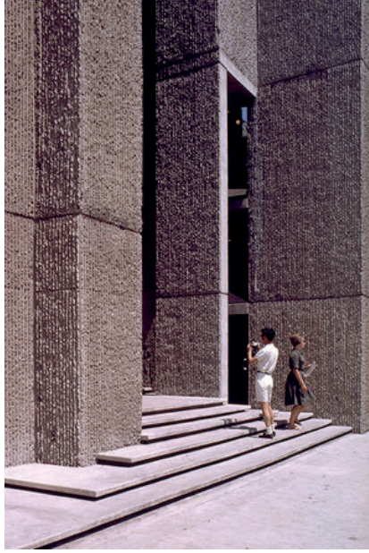
Resim 15: Yale Mimarlık Okulu cephesinde yer alan beton kütleler ve 'kadife' beton yüzeyler.
