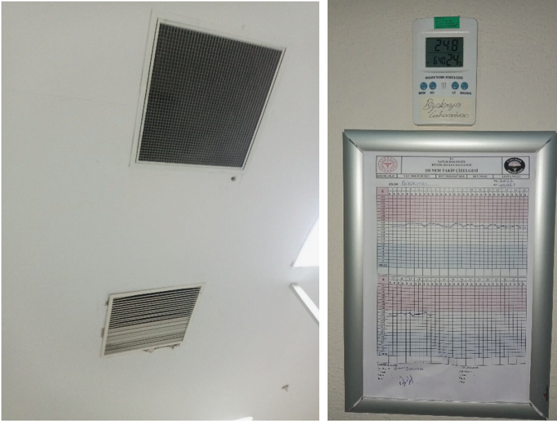
Şekil 5. 25. Havalandırma kanalları ve ısı nem takip tablosu
