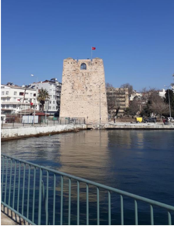
Şekil 105. Deniz kenarında sağlam kalmış Sinop kale surları (Fotoğraf: Müslüm Aydın)
