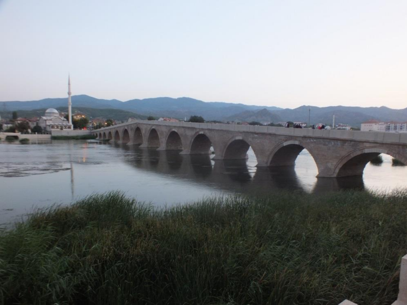
Şekil 101. Osmancık II. Bayezid Köprüsü günümüz görünümü (Fotoğraf: Müslüm Aydın)
