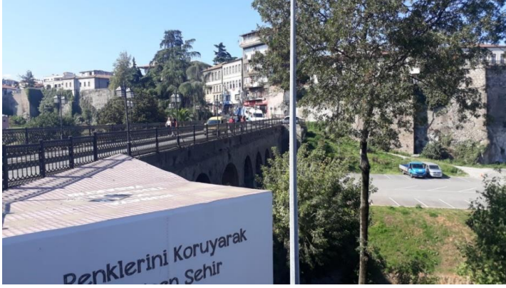
Şekil 94. Trabzon Tabakhane Köprüsü'nün günümüzdeki görünümü (Fotoğraf: Müslüm Aydın)
