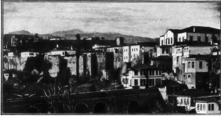
Şekil 93. Trabzon taş köprü (Tabakhane Köprüsü), 1899 (Dulany Hunter, The Princess of Trebizond).
