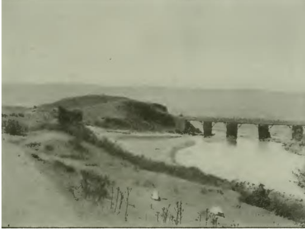
Şekil 97. Tokat-Erbaa Boğazkesen Köprüsü'nün güney tarafından görünümü, 1899 (Anderson, A Journey of Exploration in Pontus)
