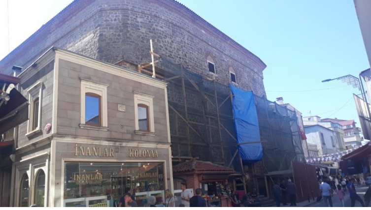
Şekil 90. Trabzon bedesteninin günümüzdeki görünümü (Fotoğraf: Müslüm Aydın)
