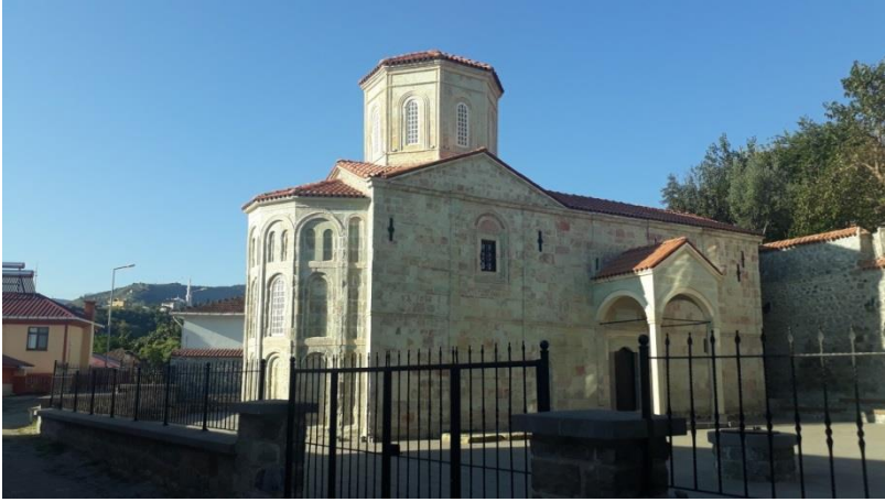
Şekil 76. St. Michael Kilisesi (Ortamahalle Müzesi) (Fotoğraf: Müslüm Aydın)
