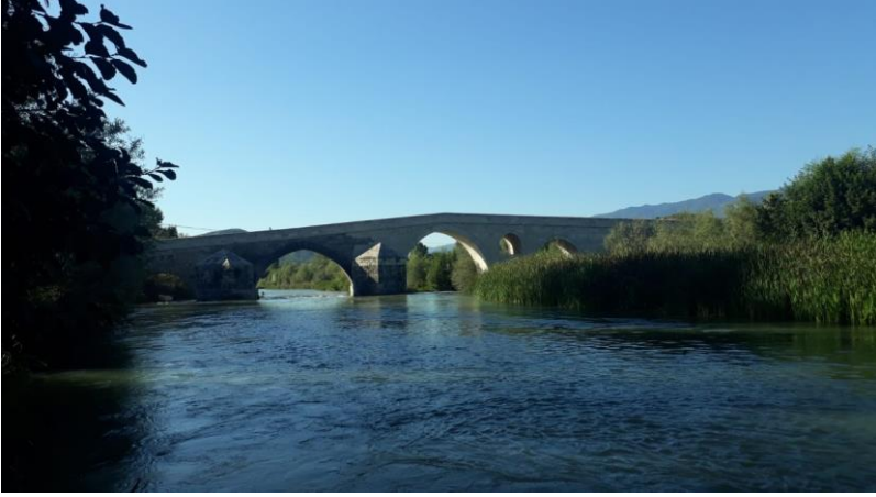
Şekil 96. Tokat Talazan Köprüsü günümüz görünümü (Fotoğraf: Müslüm Aydın)
