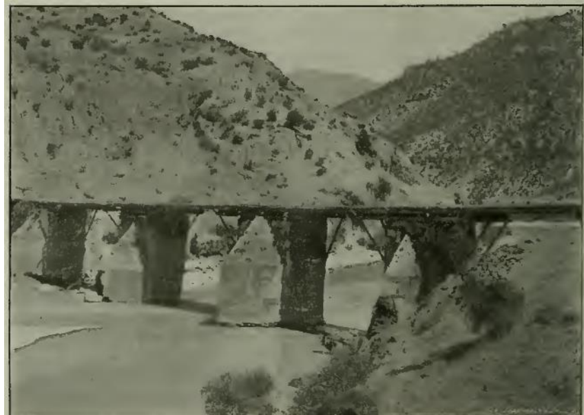
Şekil 98. Tokat-Erbaa Boğazkesen Köprüsü'nün güneyden görünümü, 1899 (Anderson, A Journey of Exploration in Pontus)
