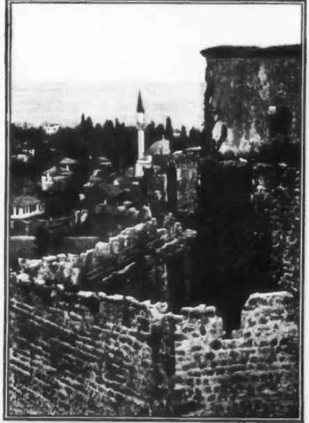
Şekil 115. Trabzon Kalesi'nin yıkık surları, 1899 (Dulany Hunter, The Princess of Trebizond)
