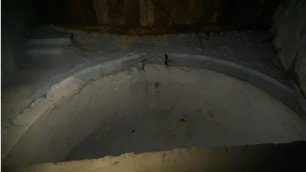
Şekil 79. Uğrak Köyündeki kiliseyi içine alan yapının iç duvarındaki kemer ve haç kabartması (Fotoğraf: Müslüm Aydın)
