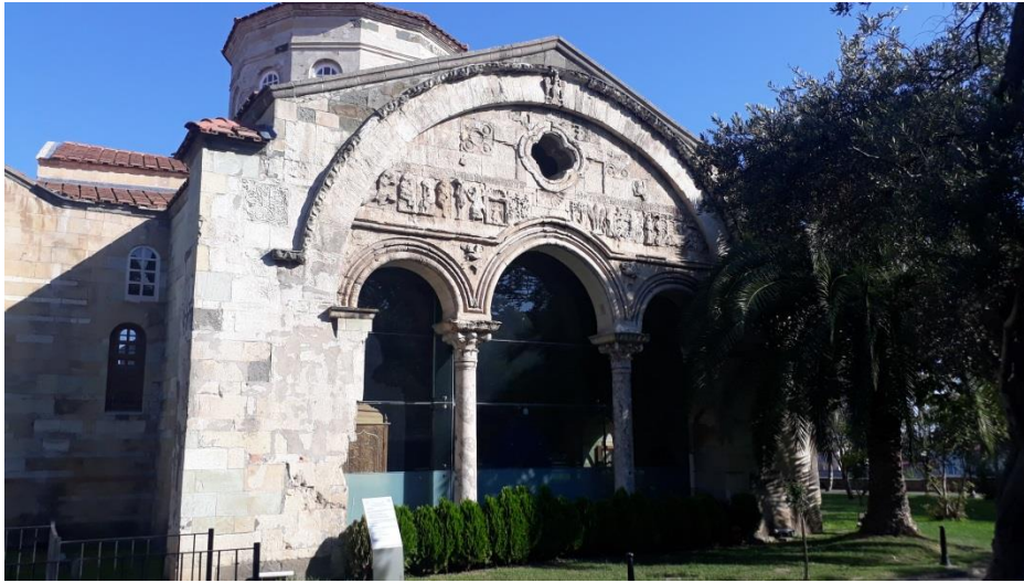
Şekil 48. Trabzon Ayasofya Camii güney cephenin günümüzdeki görünümü (Fotoğraf: Müslüm Aydın)
