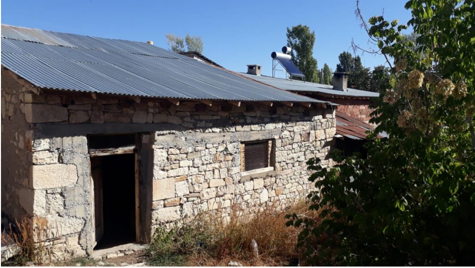
Şekil 78. Uğrak Köyündeki kiliseyi içine alan yapı (Fotoğraf: Müslüm Aydın)
