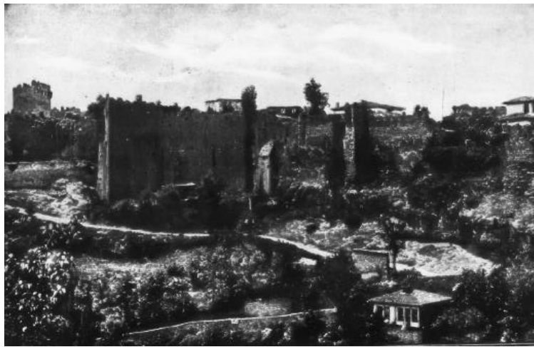
Şekil 116. Trabzon Kalesi'nin yıkık surları, 1899 (Dulany Hunter, The Princess of Trebizond)
