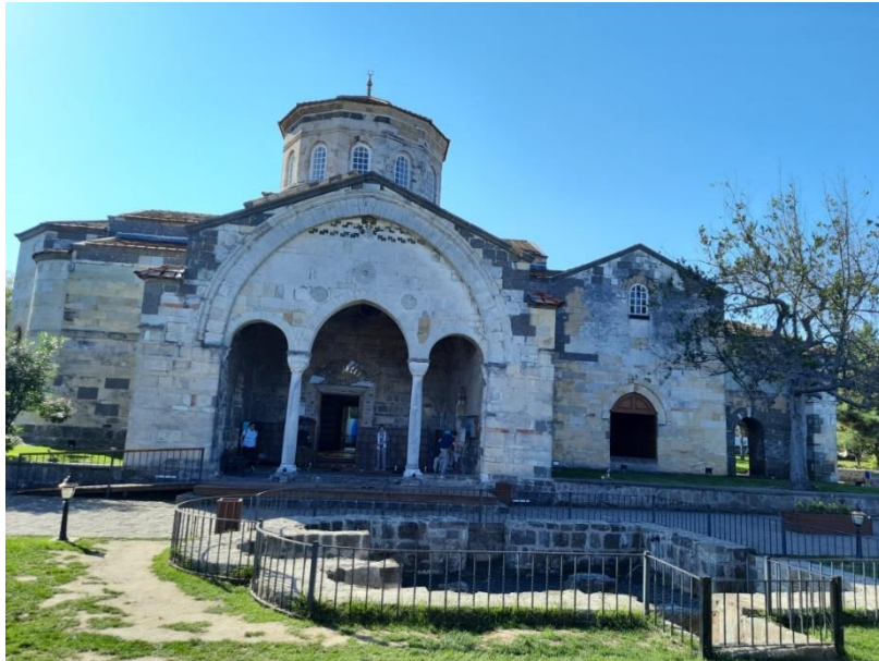
Şekil 50. Trabzon Ayasofya Camii kuzey revakları ve yıkılan vaftizhane temellerinin günümüzdeki görünümü (Fotoğraf: Müslüm Aydın)
