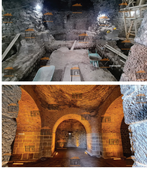
Resim 15. Evlibeden burcu onarım öncesi ve sonrası
