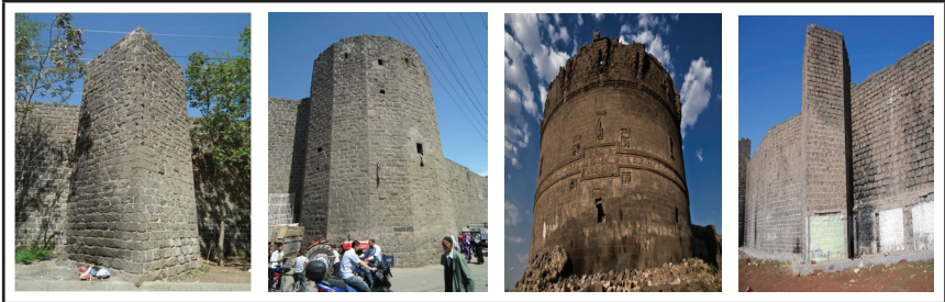
Resim 3. Diyarbakır surlarında burç tipleri
