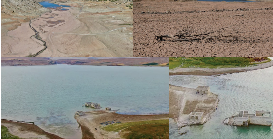
Şekil 1. Elazığ'da kuraklık nedeni ile baraj sularının çekilmesi ve yaklaşık 75 yıllık olduğu tahmin edilen köy okulu ortaya çıkması (Sabah, 2021).
